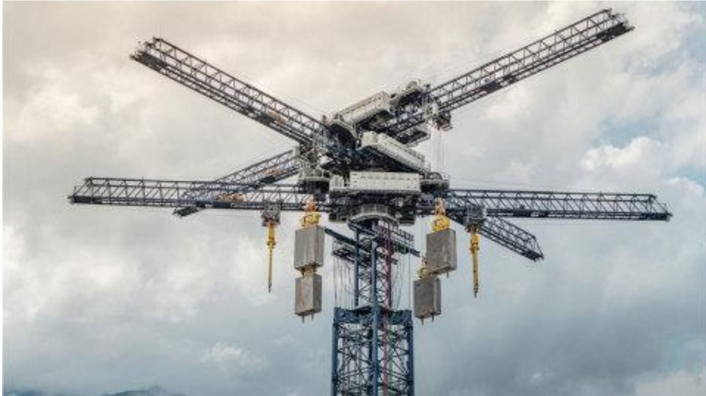
*Batterie der Zukunft setzt auf Beton. Foto: Energy Vault (ingenieur.de 2024.02.12)*
